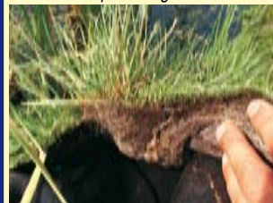
Die Ufermatte bewurzelt perfekt. Ein Teil der Wurzeln dringt durch die Matte und bildet darunter ein dichtes Geflecht.
