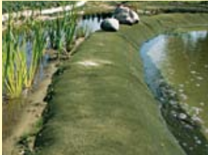
Start: Der Uferwall ist mit der Ufermatte abgedeckt. Schon jetzt perfekter Schutz.
